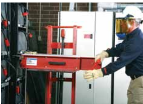
A nagyobb UPS típusoknál helyszíni preventív karbantartás szükséges az optimális teljesítmény érdekében
